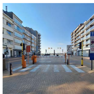
Een wirwar aan verkeerssignalisatie ter hoogte van het dijkplein.
