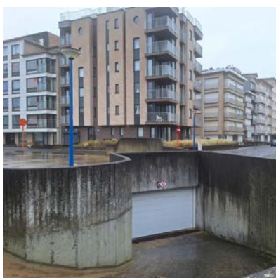
Beperkte vergroeningskansen op sommige pleinen omwille van ondergrondse parkeergarages
